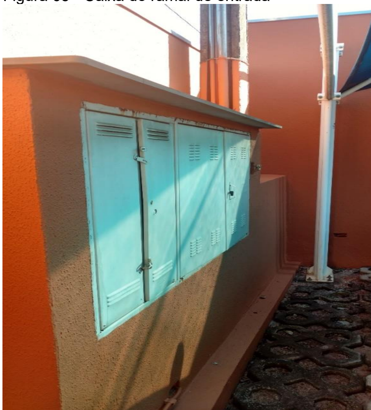
Figura 65 - Caixa do ramal de entrada
