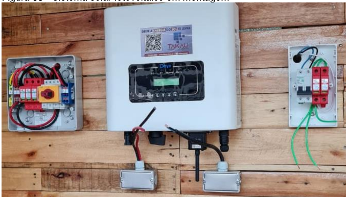
Figura 53 - Sistema solar fotovoltaico em montagem
