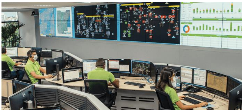
Figura 2 - Sala de suporte.
