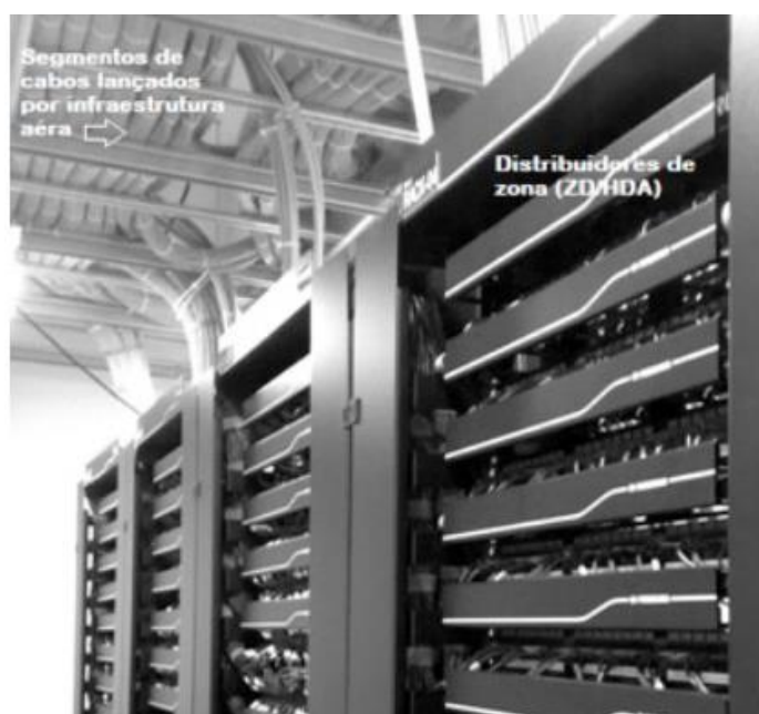
Figura 31 - Cabeamento aéreo.
