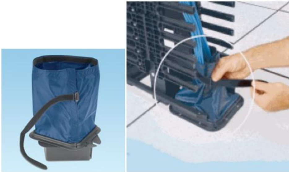
Figura 46 - Vedação das aberturas de placas de piso.
