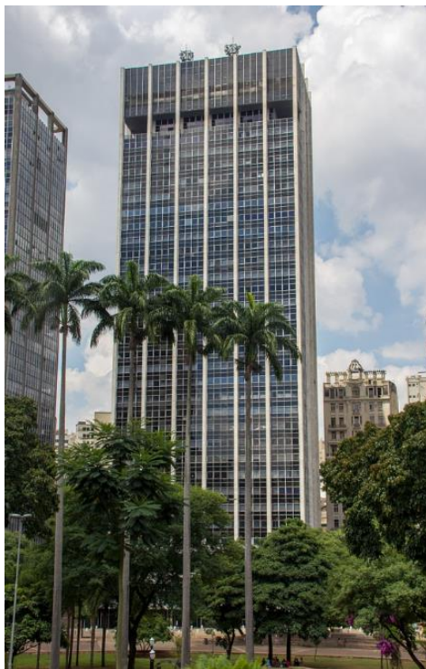
Figura 22 - Data Center em um espaço compartilhado.
