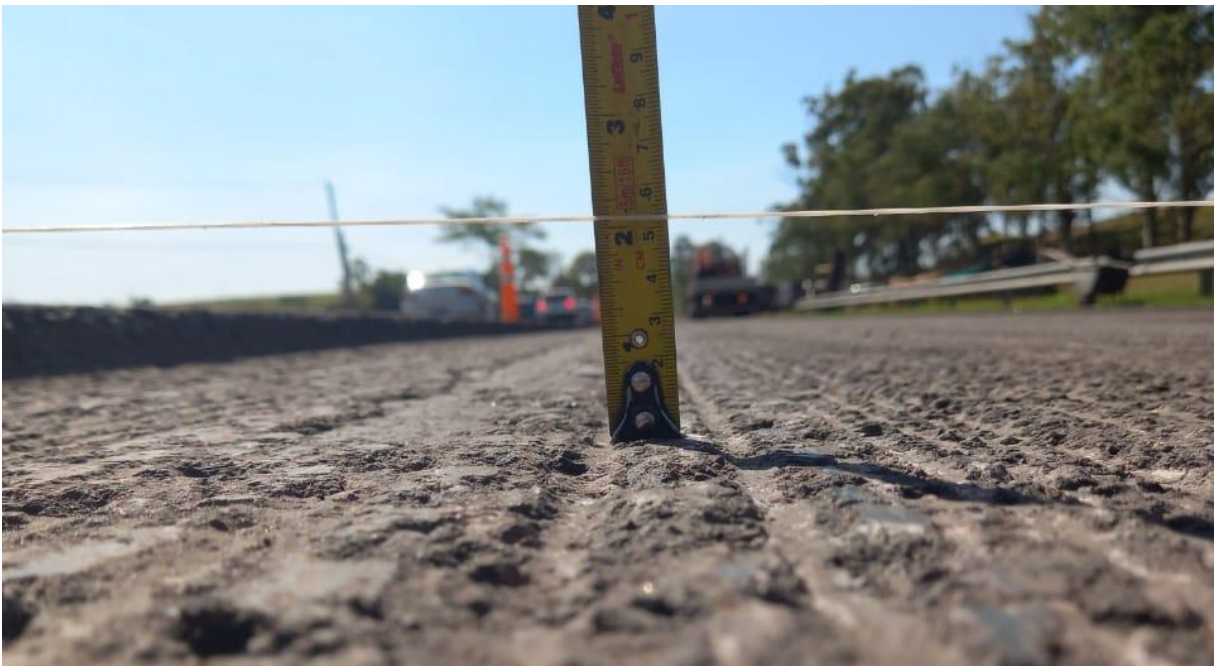
Figura 21 - Utilização da fita métrica para conferência de espessura localizada.
