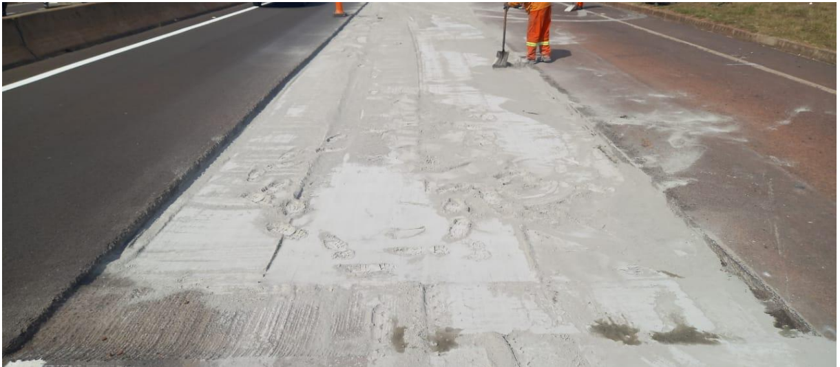
Figura 10 - Aplicação do cimento de reciclagem de base.
