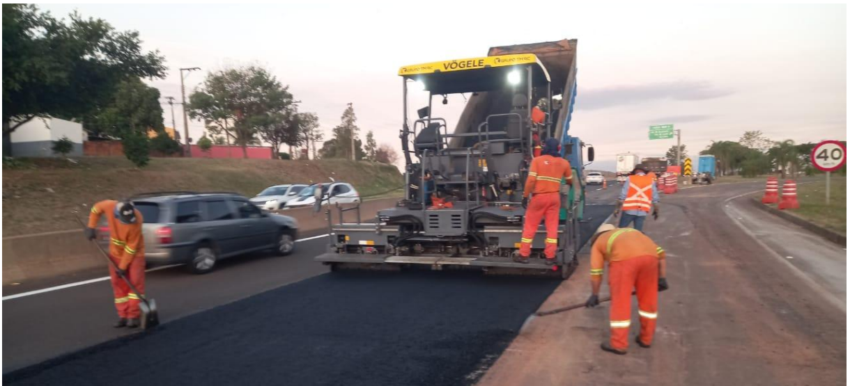
Figura 15 - Vibroacabadora.
