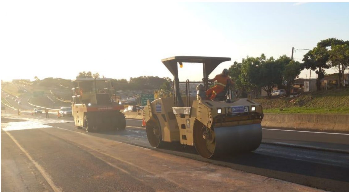
Figura 23 - O rolo compactador pneu e o rolo chapa.
