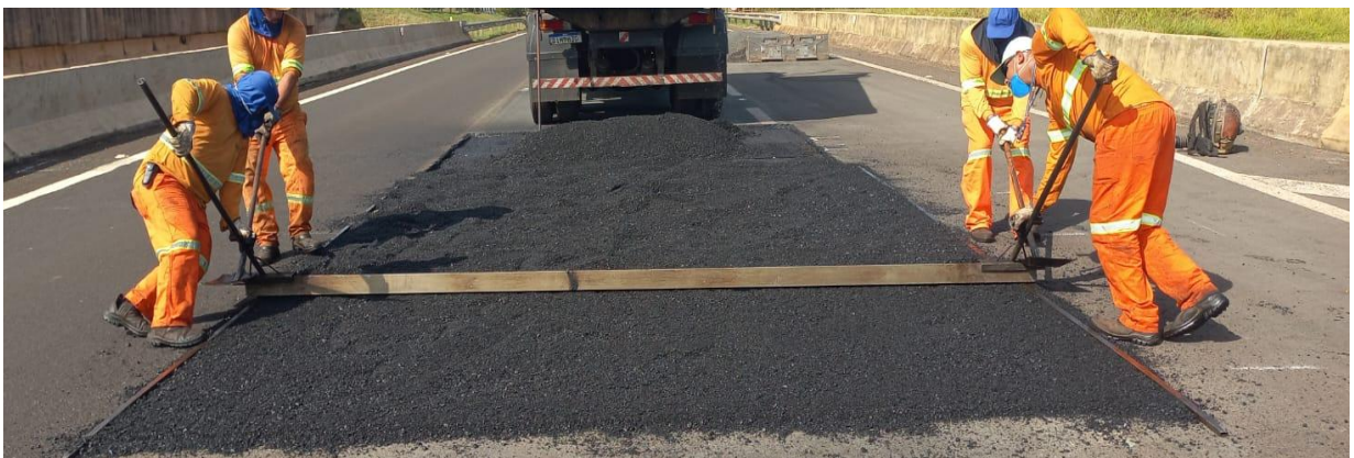
Figura 19 - Utilização da régua niveladora de pedreiro.
