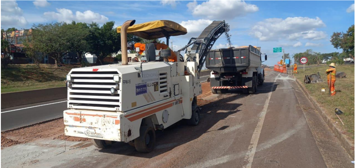
Figura 14 - Fresadora 1000.
