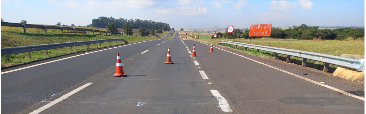
Figura 18 - Equipamentos de sinalização.
