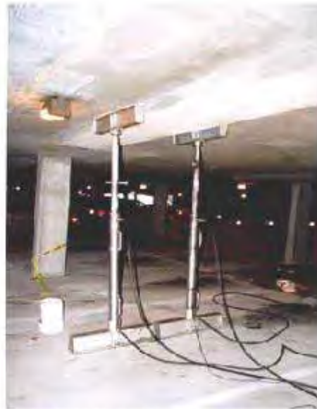
Macacos hidráulicos instalados FONTE: Mettemeyer e Nanni (1999)
