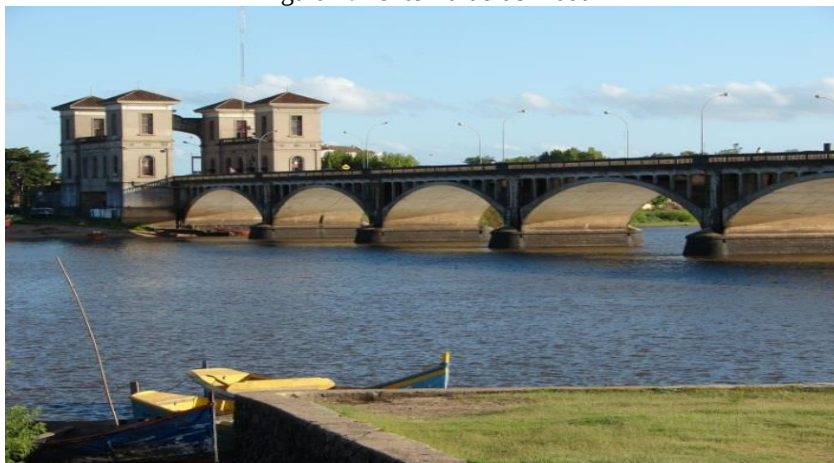
Figura 2: Ponte Barão de Mauá
