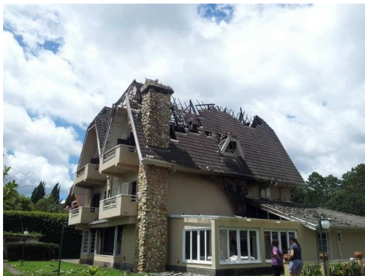
Figura 10 – Casa atingida por descarga atmosférica
