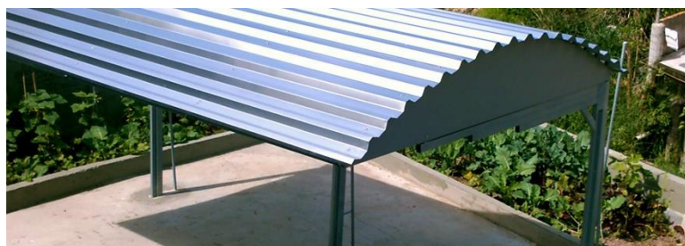
Figura 18 – Cobertura feita de telhas galvanizadas
