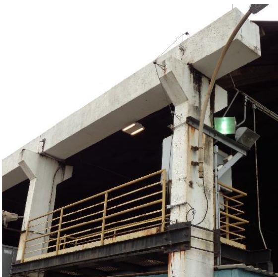
Figura 58 – Estrutura metálica próxima a descida
