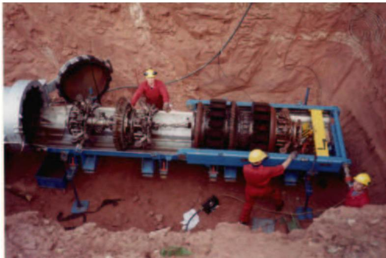
Figura 2.5: *TranScan™* sendo lançado em tubulação metálica. Figura retirada do site de empresa General Electric Power Systems.
