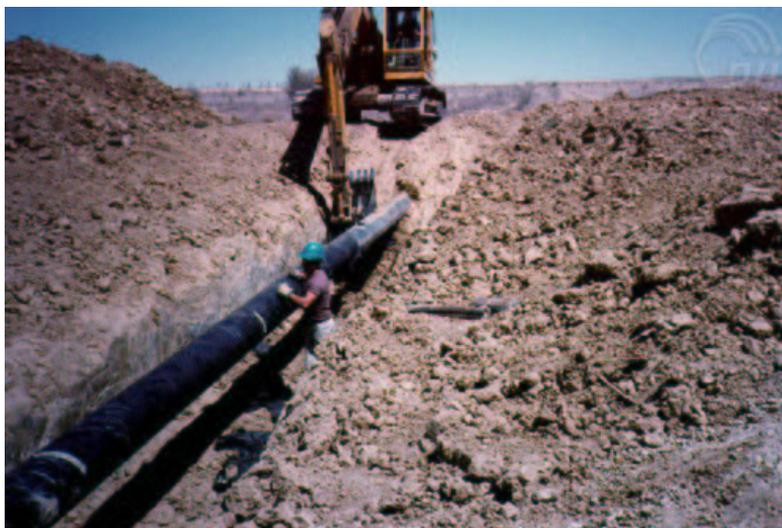
Figura 2.1: Instalação de duto subterrâneo. Figura retirada do site de empresa General Electric Power Systems
