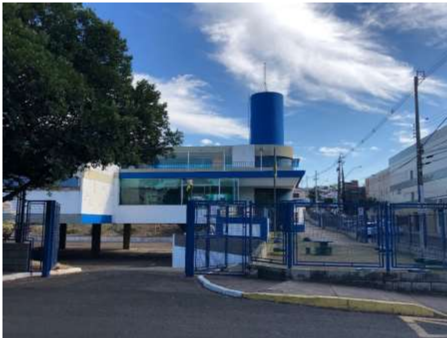
Imagem 41 - Acesso ao estacionamento da Uniesp S.A.
