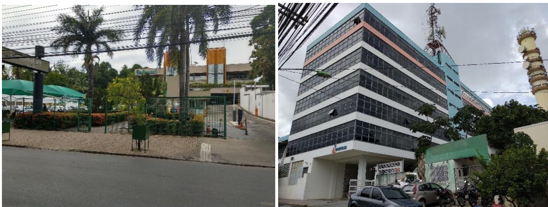
Fotos 38 e 39: Cuiabá. Sede da Unimed Cuiabá (esquerda) e da Energisa-MT (direita), ambas posicionadas entre as 1000 maiores empresas do Brasil. Fonte: Rhafael Borges (2018).
