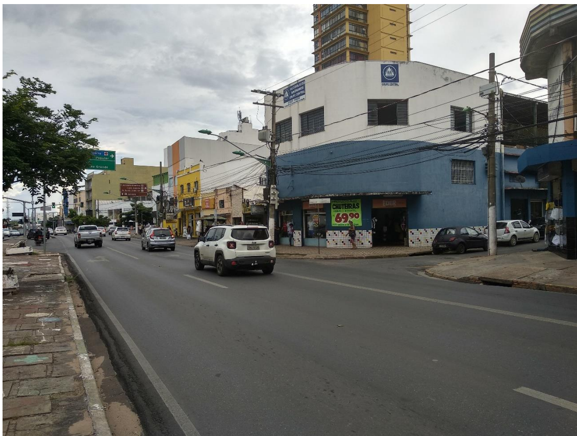
Foto 6: Cuiabá. Esquina entre a Avenida Tenente Coronel Duarte (Avenida da Prainha), via estrutural construída no século XX, e a rua Cândido Mariano, via histórica construída no século XVIII. 2018.
