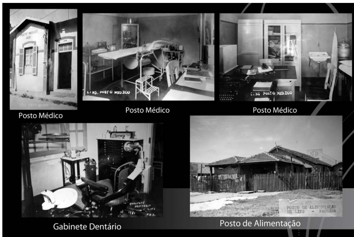
Figura 18: Estrutura trabalhista – posto médico, gabinete dentário e posto de alimentação da Estrada de Ferro Noroeste do Brasil (NOB) em Lins.
