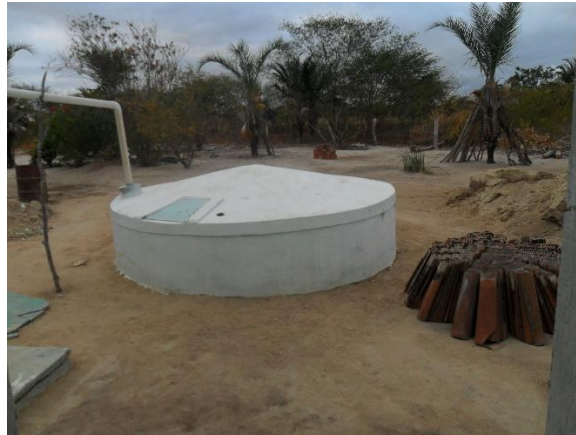
Figura 2 - Cisterna captação da água da chuva para consumo humano.
