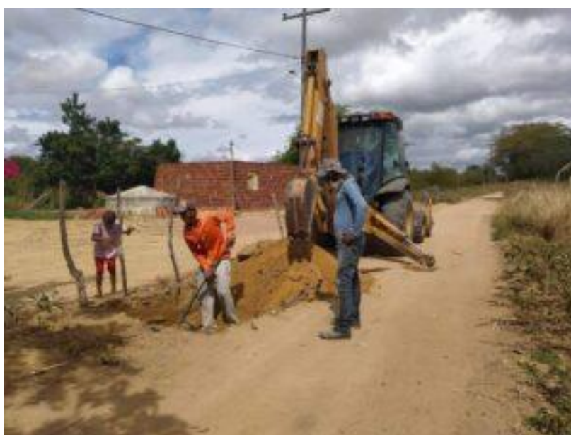
Figura 73 - Escavação e construção do sistema de abastecimento.
