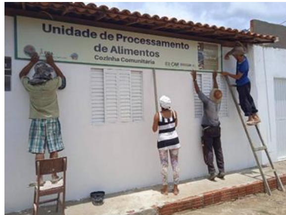
Figura 37 - Mutirão da construção da cozinha comunitária.
