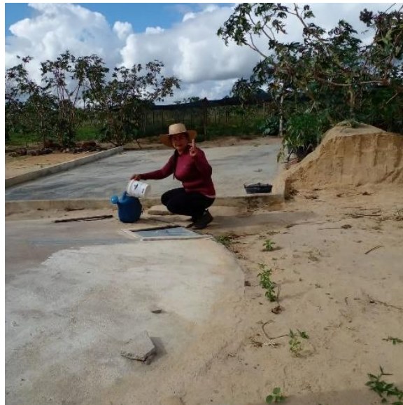
Figura 3 - Cisterna-calçada captação de água para produção.
