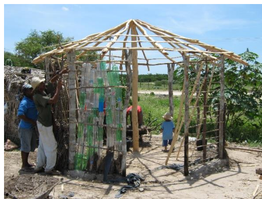
Figura 54 - Construção da Biblioteca de bioconstrução do Acampamento Terra Nossa.
