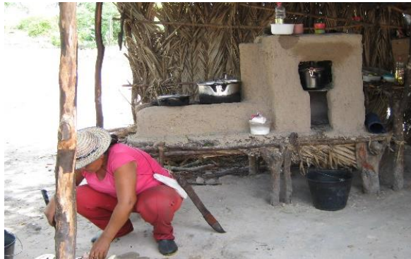
Figura 55 - Construção do fogão bioconstrução do Acampamento Terra Nossa.
