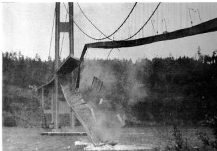
Figura 11 – Colapso da ponte Tacoma Narrows devido a ressonância.
