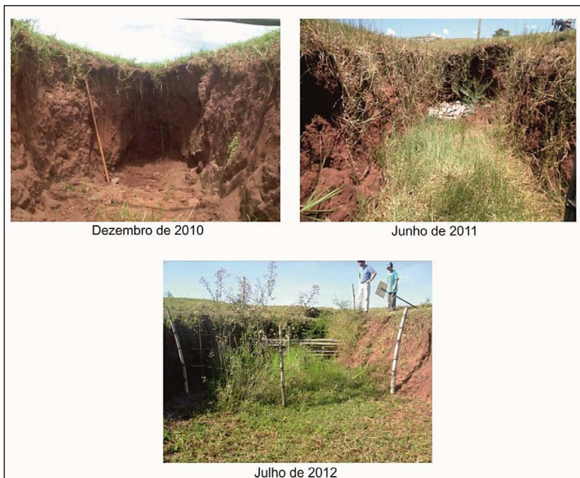
Figura 22- Recuperação da erosão (Ravina B)
