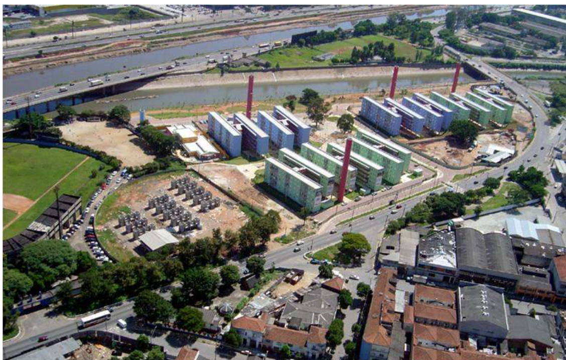
Foto 6 : vista geral do conjunto ainda em fase de finalização Fonte: COHAB (Companhia Metropolitana de Habitação), 2007
