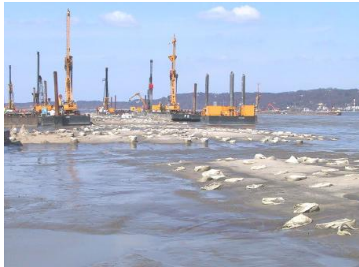
Figura 3.14 - Instalação das colunas Ringtrac®.
