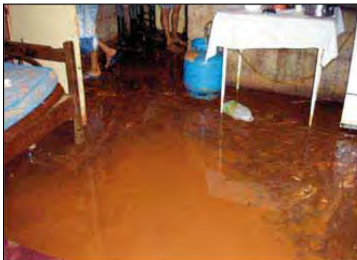
Foto 3: Casa Alagada no Jardim São Judas Tadeu.
