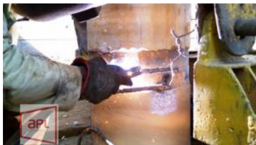
Figura 3 – Anéis soldados para emenda.
