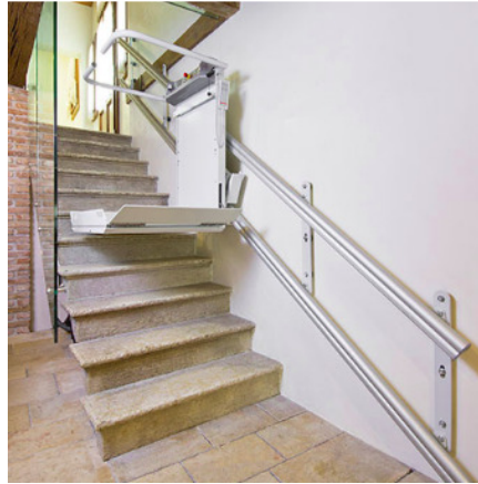
Figura 1 - Plataforma tipo plano inclinado.
