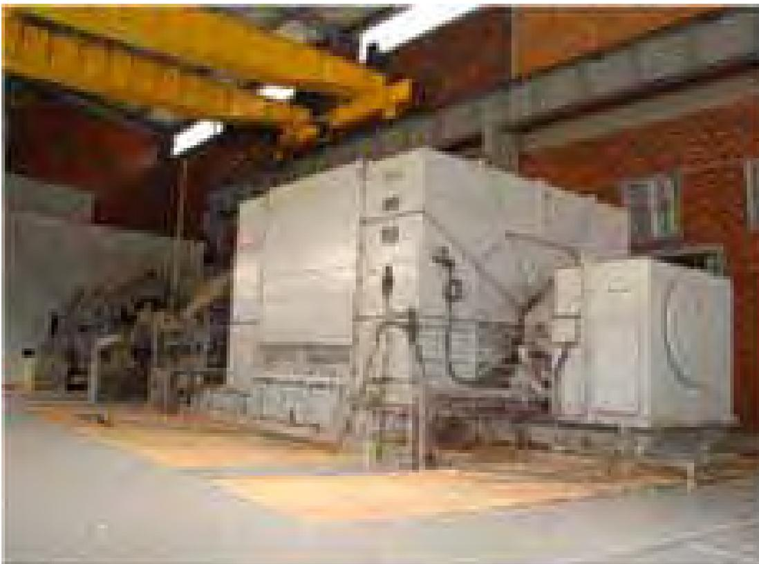
**Figura 3.9:** Turbogenerador de extração – condensação 32 MW
