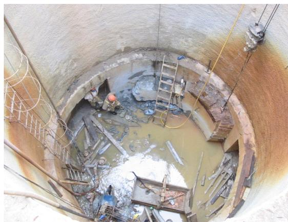
Figura 5 - Obras de construção de um interceptor de esgoto às margens do rio Tietê – *Projeto Tietê*.
