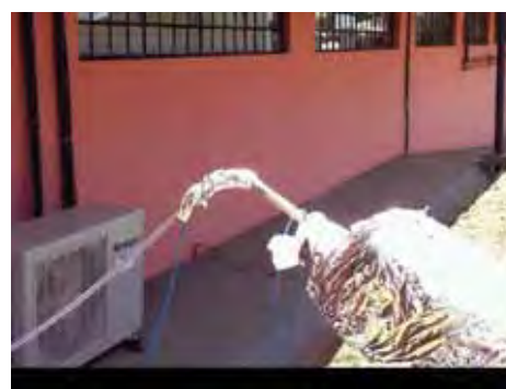
Foto 11: Imagem de luz visível do tubo de entrada de água fria às 13:37h
