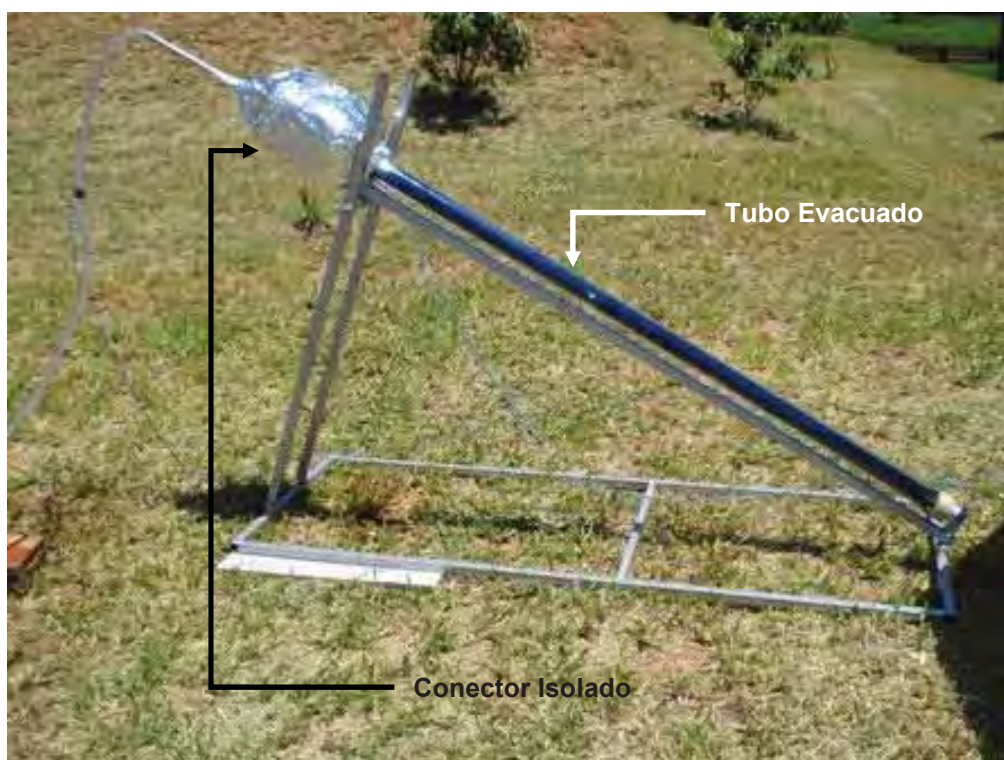
Foto 8: Instalação do tubo evacuado e conector de passagem
