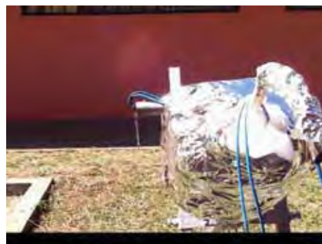
Foto 13: Imagem de luz visível da saída de água quente às 15:05h
