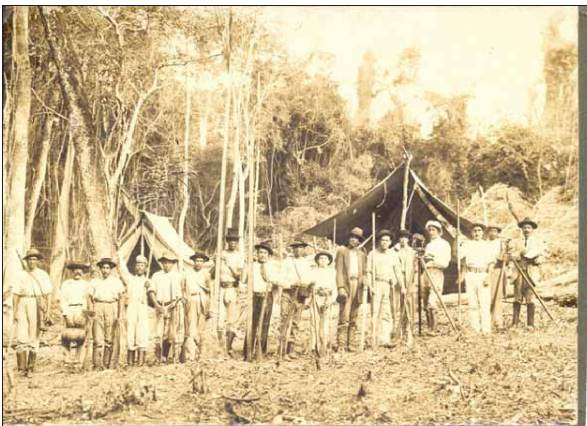
Figura 1: Trabalhadores na derrubada das matas para a construção de estradas e ferrovias em Presidente Prudente – SP.
