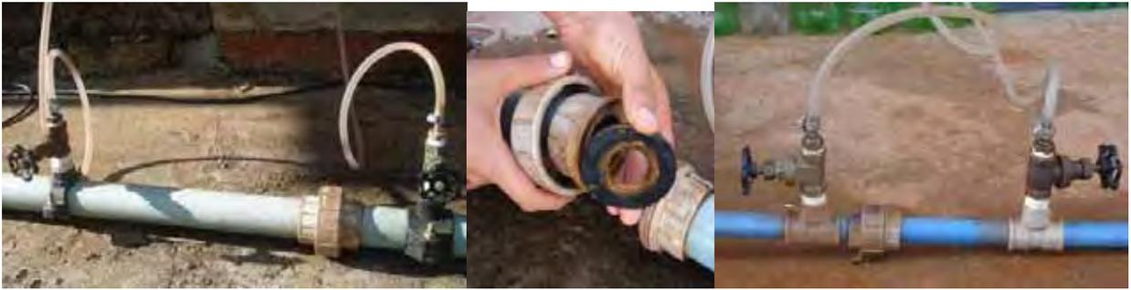
FIGURA 10. Medidores de vazão (placa de orifício) instalados nos dutos do “overflow” e “underflow”.
