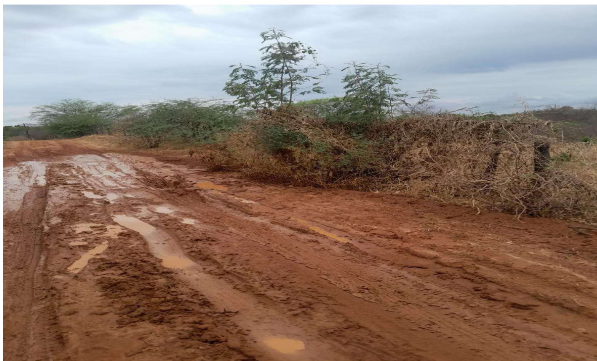
Figura 1 - Infraestrutura da estrada que dá acesso à comunidade
