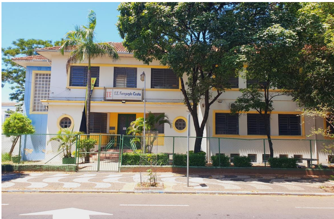
Figura 13: Fachada frontal da Escola Estadual Fernando Costa em Presidente Prudente-SP.
