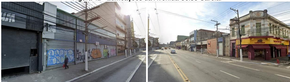
Figura 42 - Edificações da Avenida Celso Garcia.
