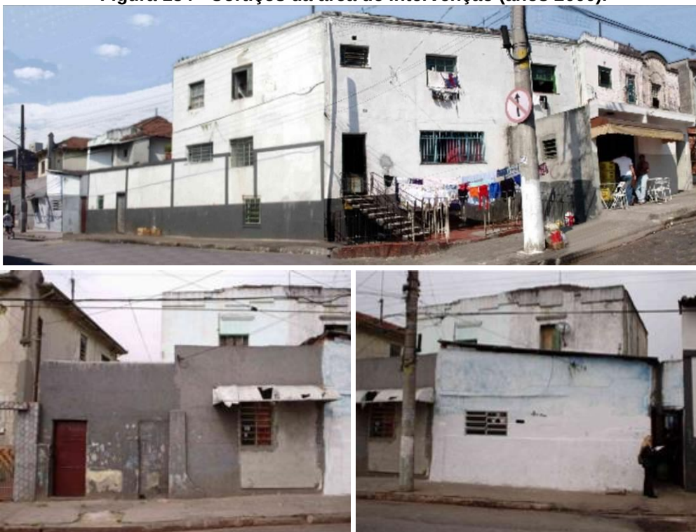
Figura 134 - Cortiços da área de intervenção (anos 2000).
