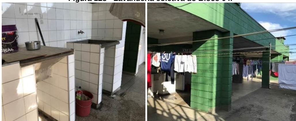
Figura 128 - Lavanderia coletiva do Bloco 04.
