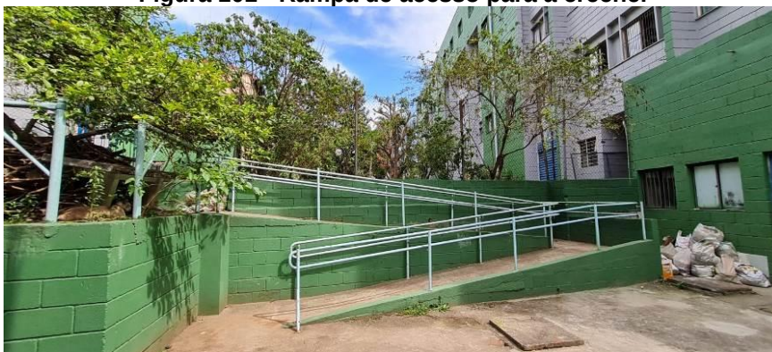
Figura 101 - Rampa de acesso para a creche.
