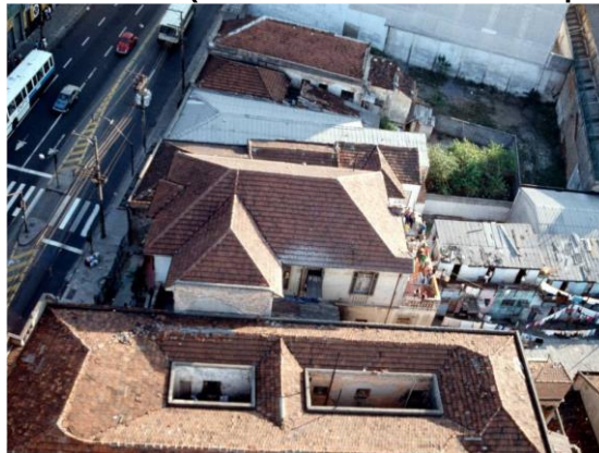
Figura 64 - Perspectiva aérea dos cortiços preexistentes (Casarão Cutrale em destaque).
