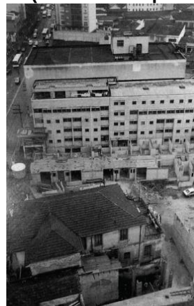
Figura 70 - Execução da obra do Conjunto Habitacional (Bloco 01 em primeiro plano).
