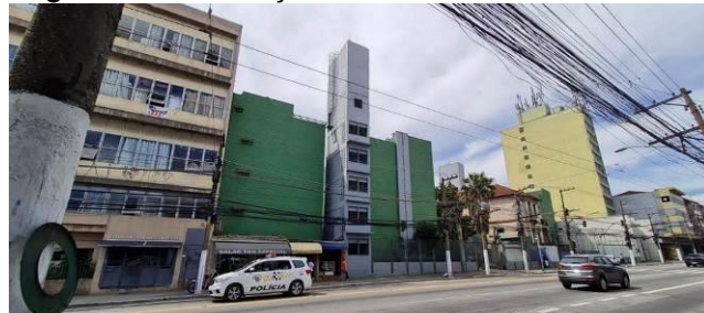
Figura 40 - Edificações da Avenida Celso Garcia.
