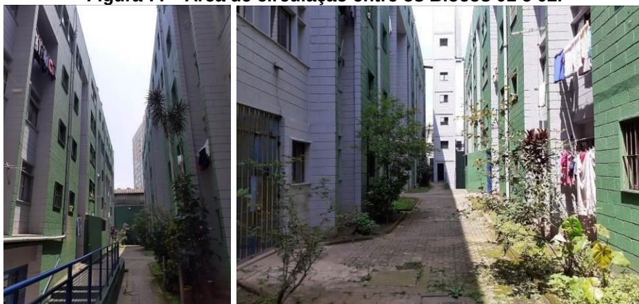
Figura 77 - Área de circulação entre os Blocos 01 e 02.
