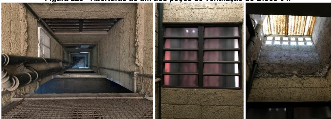
Figura 125 - Aberturas de um dos poços de ventilação do Bloco 04.
