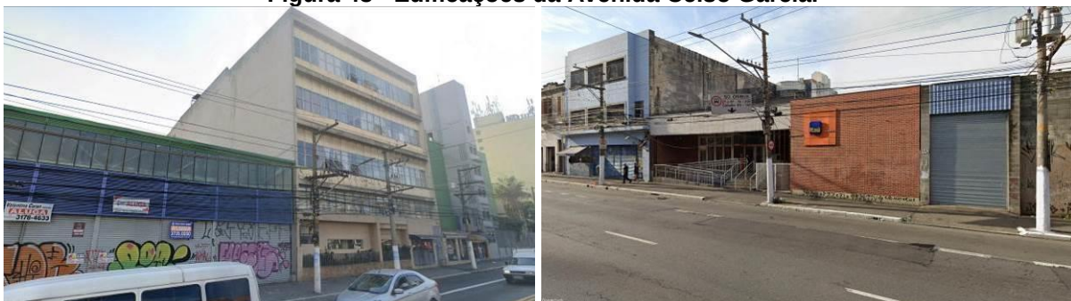
Figura 43 - Edificações da Avenida Celso Garcia.
