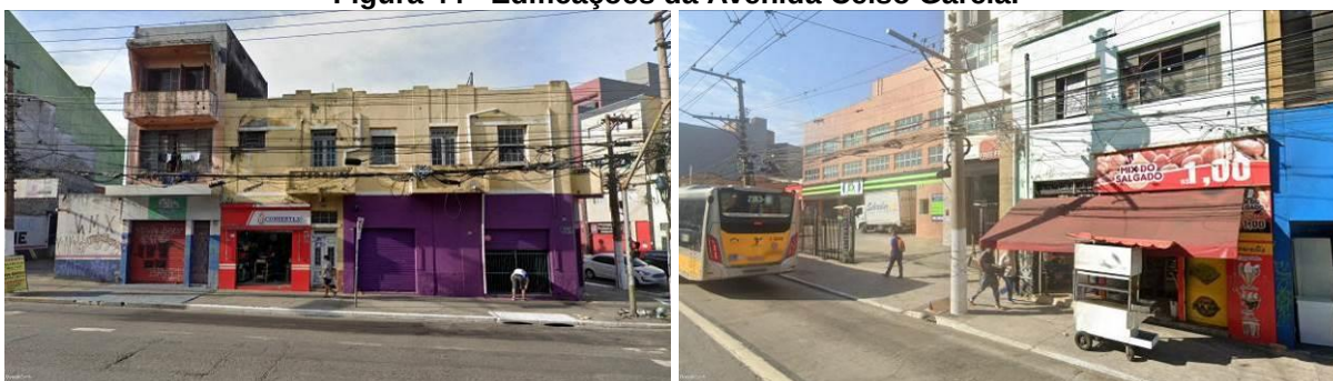
Figura 44 - Edificações da Avenida Celso Garcia.
