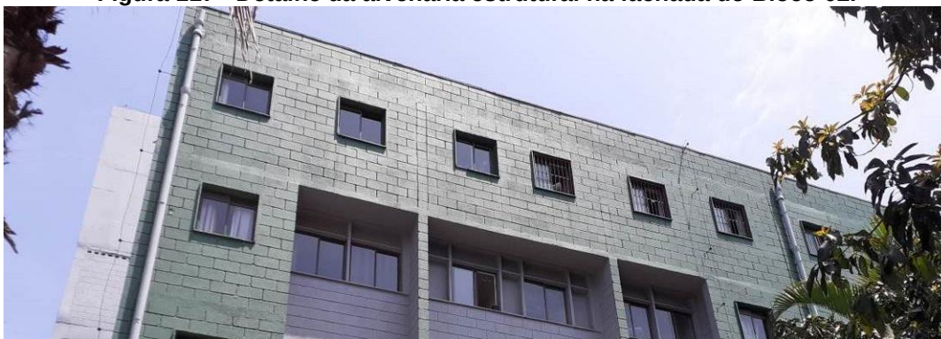
Figura 117 - Detalhe da alvenaria estrutural na fachada do Bloco 02.
