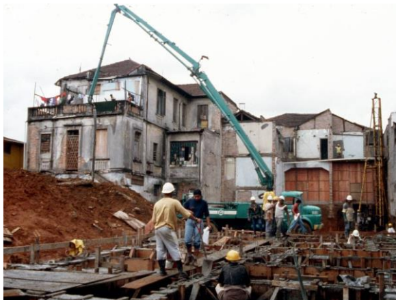
Figura 69 - Execução da obra do Conjunto Habitacional Casarão Celso Garcia.
