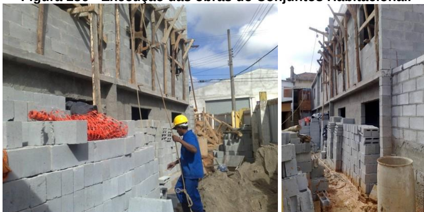
Figura 136 - Execução das obras do Conjuntos Habitacional.
