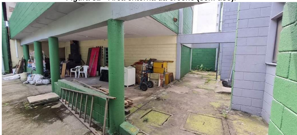
Figura 82 - Área externa da creche (sem uso).
