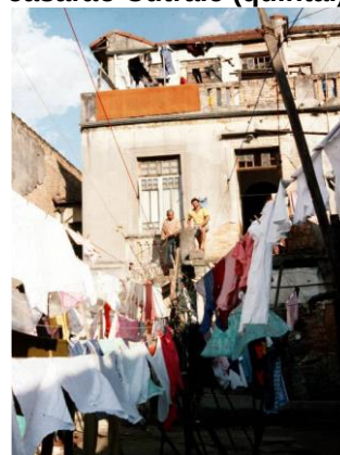
Figura 66 - Área posterior do cortiço do casarão Cutrale (quintal).
