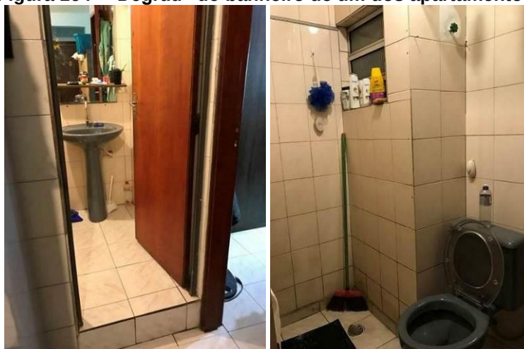
Figura 164 - “Degrau” do banheiro de um dos apartamentos.
