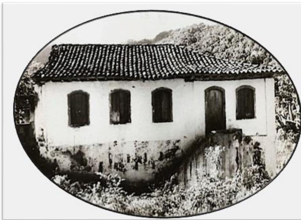
Figura 110 – Fachada lateral do engenho Pedra Branca, em Paraty, com escada para acesso à casa-grande.
