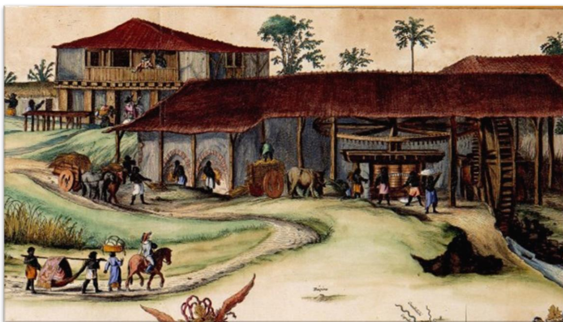
Figura 91 - Implantação de engenho à meia-encosta, com capela na parte mais alta do terreno.
