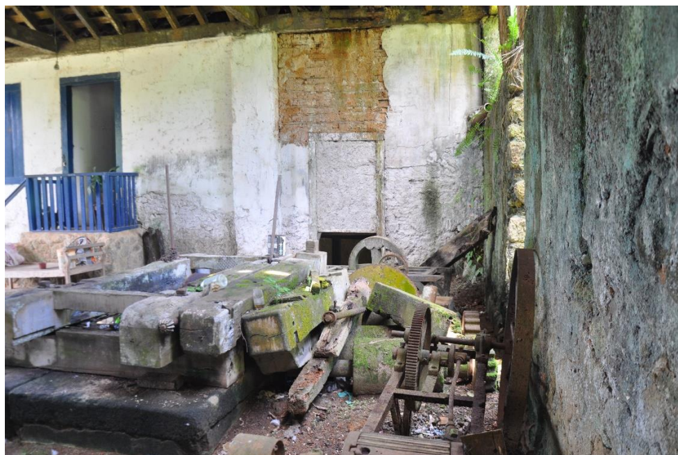
Figura 67 – Área de moagem da cana: a parede do lado direito conectava a moenda à antiga roda d'água.
