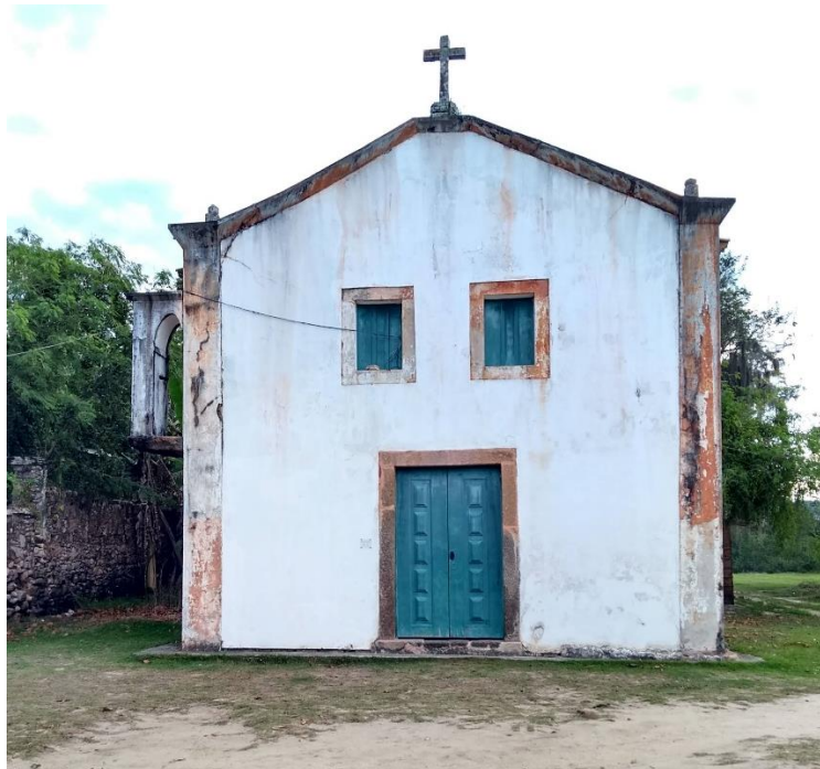
Figura 125 – Capela do Engenho de Paraty Mirim, edificado no século XVIII.
