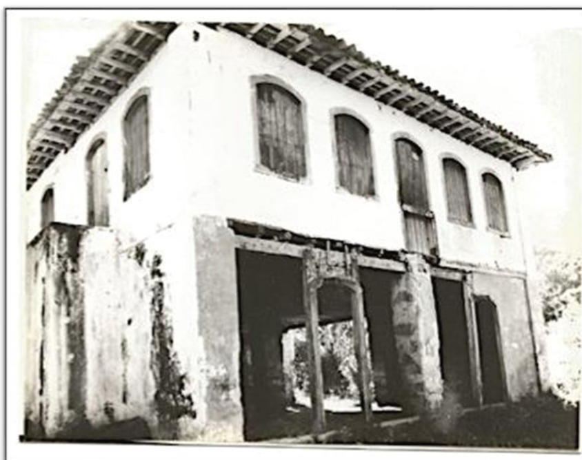
Figura 111 – Fachada principal do Engenho Pedra Branca, em Paraty. Pavimento térreo com pé direito alto, para armazenar dornas e tonéis.
