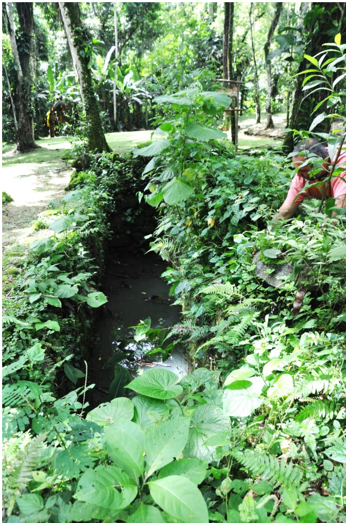
Figura 76 – Inferno da roda das ruínas do engenho da Fazenda Bananal de cima.
