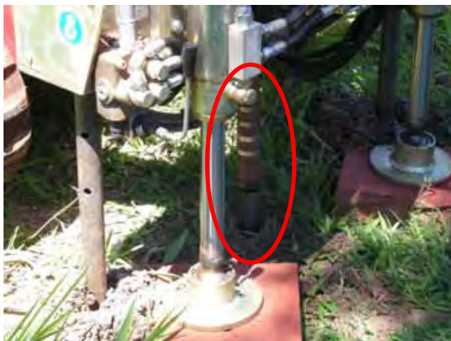
Figura 57 – Sensores sendo cravados. No detalhe, o sensor de resistividade
