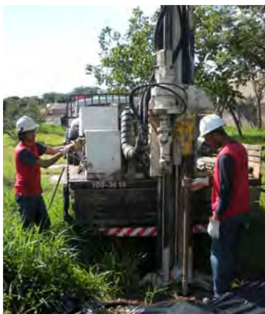
Figura 39 – Composição sendo cravada com equipamento mecanizado
