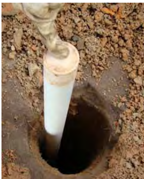
Figura 51 – Poço instalado após sondagem com Trado Sólido
