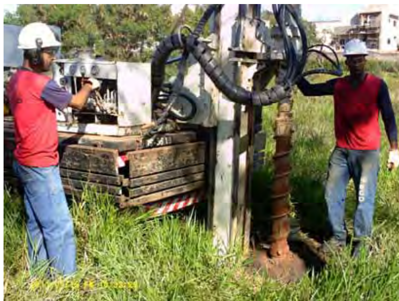
Figura 27 – Sonda ECD-SMA-01 montada sobre caminhão
