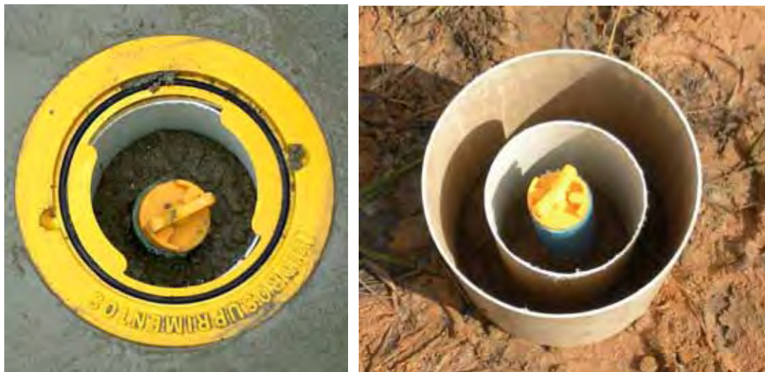
Figura 49 – Vista do poço de monitoramento acabado (à esquerda) e em acabamento (à direita)
