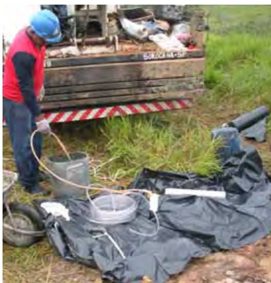
Figura 50 – Utilização da bomba elétrica submersível para desenvolvimento dos poços.
