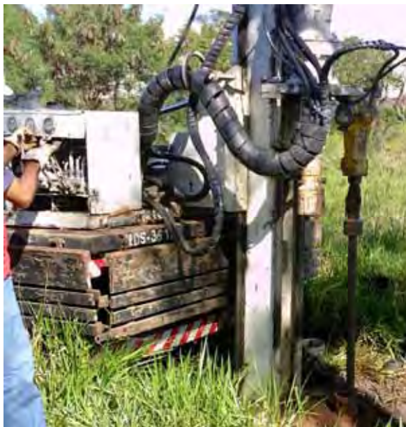
Figura 25 – Cravação da composição com equipamento mecanizado, acoplado à sonda hidráulica ECD-SMA-01
