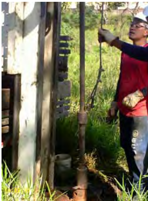
Figura 40 – Retirada da composição com equipamento mecanizado
