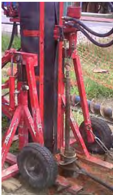
Figura 41 – Composição sendo retirada de dentro dos Trados Ocos
