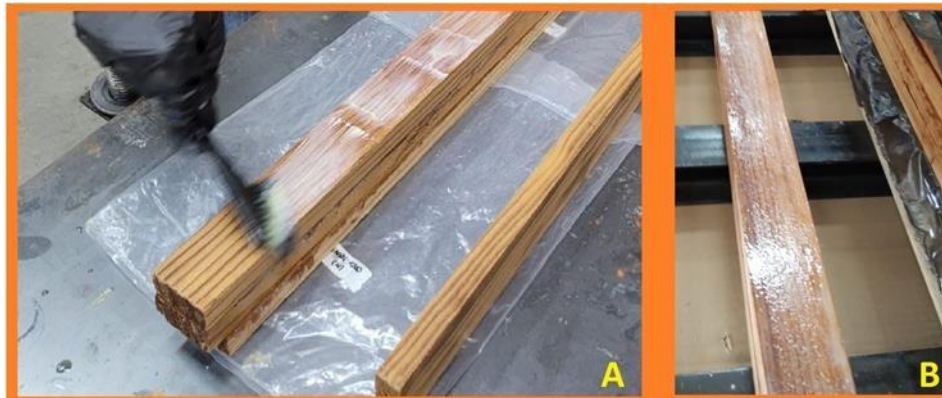
Figura 23 – Colagem das vigas, aplicação do adesivo (A), lamela com adesivo (B).
