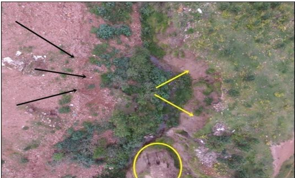
Figura 42. Aterramento da erosão.
