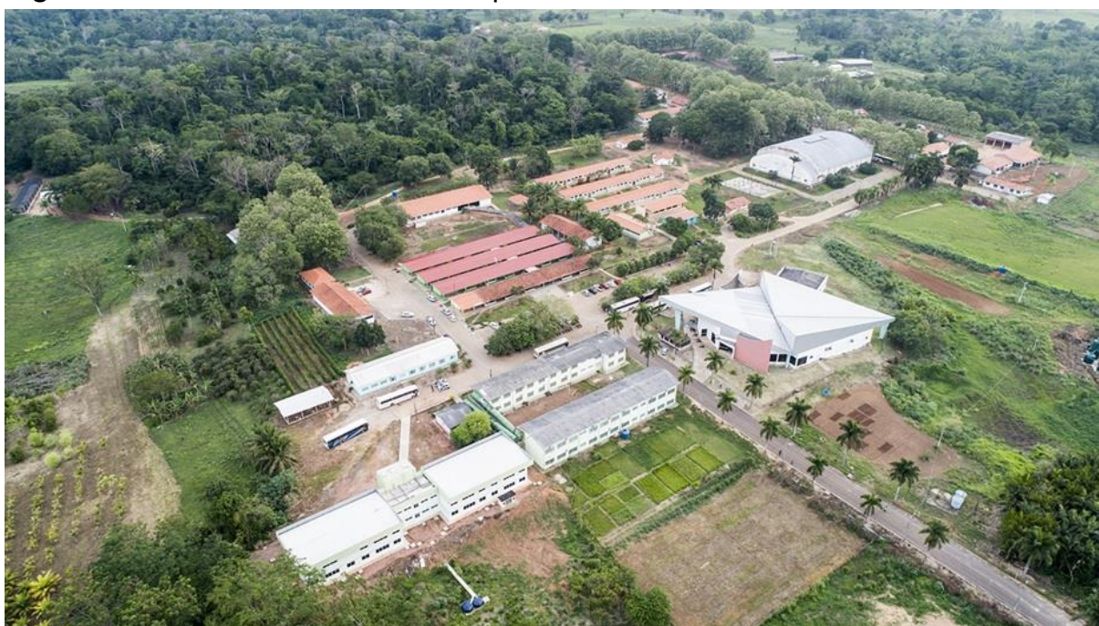
Figura 2 - Vista aérea do IFRO - campus Colorado.
