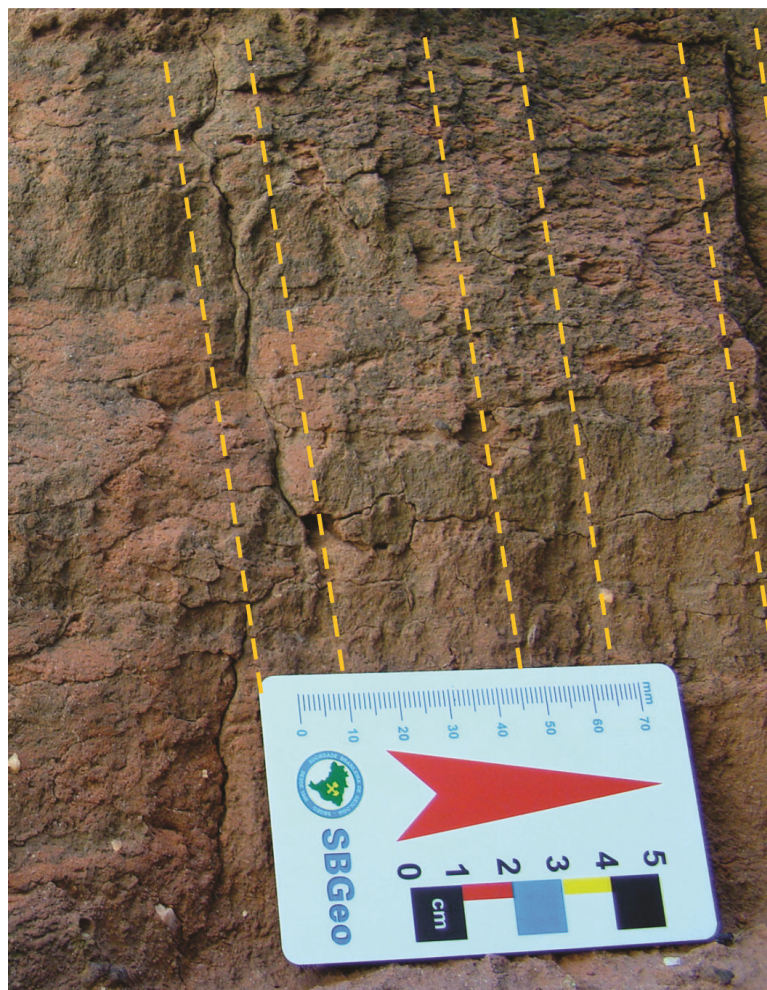
Figura 41: Ponto 16 mostrando planos de fraturas subverticais de direção NW/SE.
