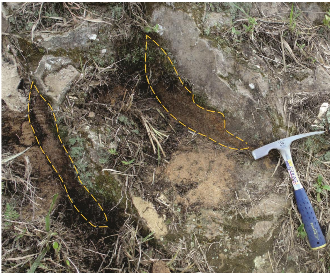
Figura 44: Ponto 28 exibindo um par de planos de fraturas sub verticais de direção NW/SE espaçados em 50cm, fechados e sem preenchimento, em arenito do Grupo Itararé.
