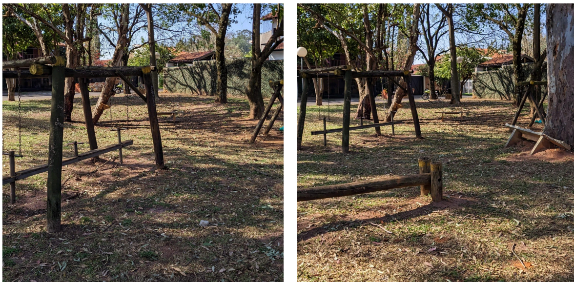
Figura 37 e 38: Parquinho de madeira com alguns bancos de cimento espalhados no interior da praça
