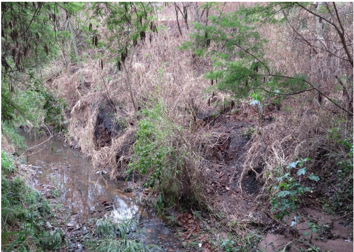
Figura 23: Taludes em torno de 8 a 10 metros de altura (Rua 22Jsp x Avenida 1)
