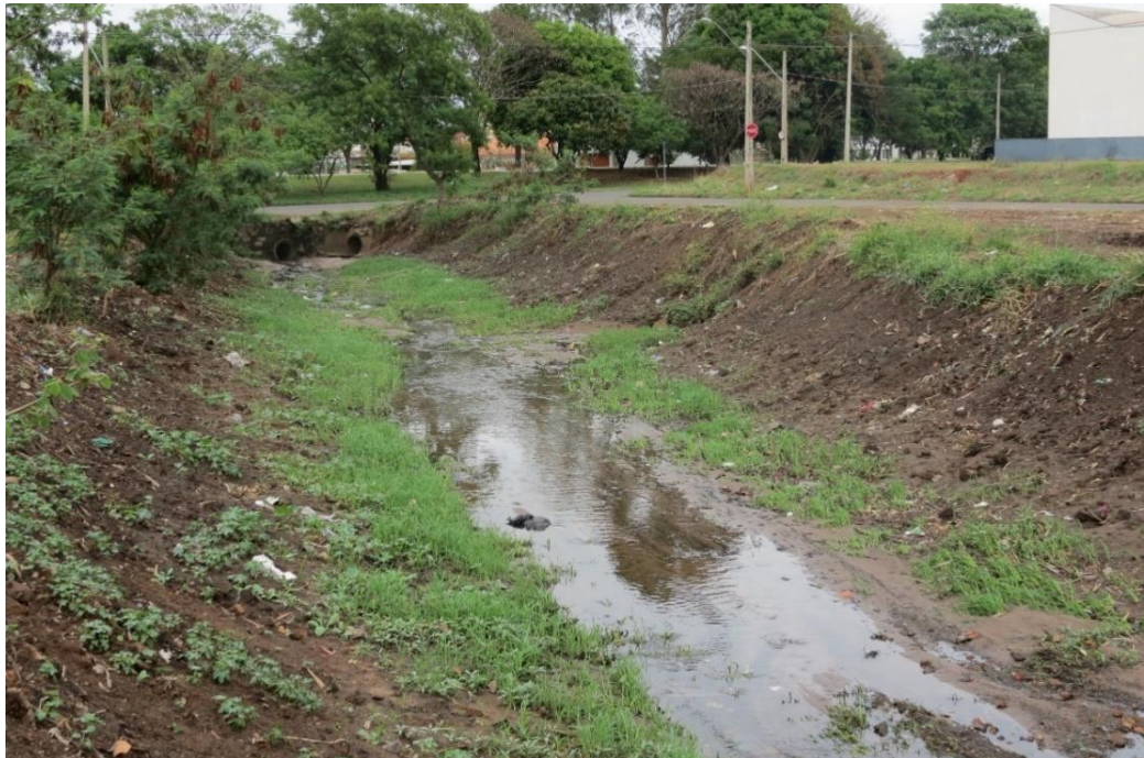
Figura 16: Alargamento do dreno próximo à área de ocorrência de inundações
