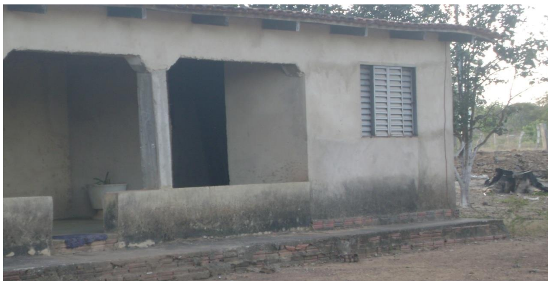
Fotografia 17 - residência camponesa no município de Tupirama
