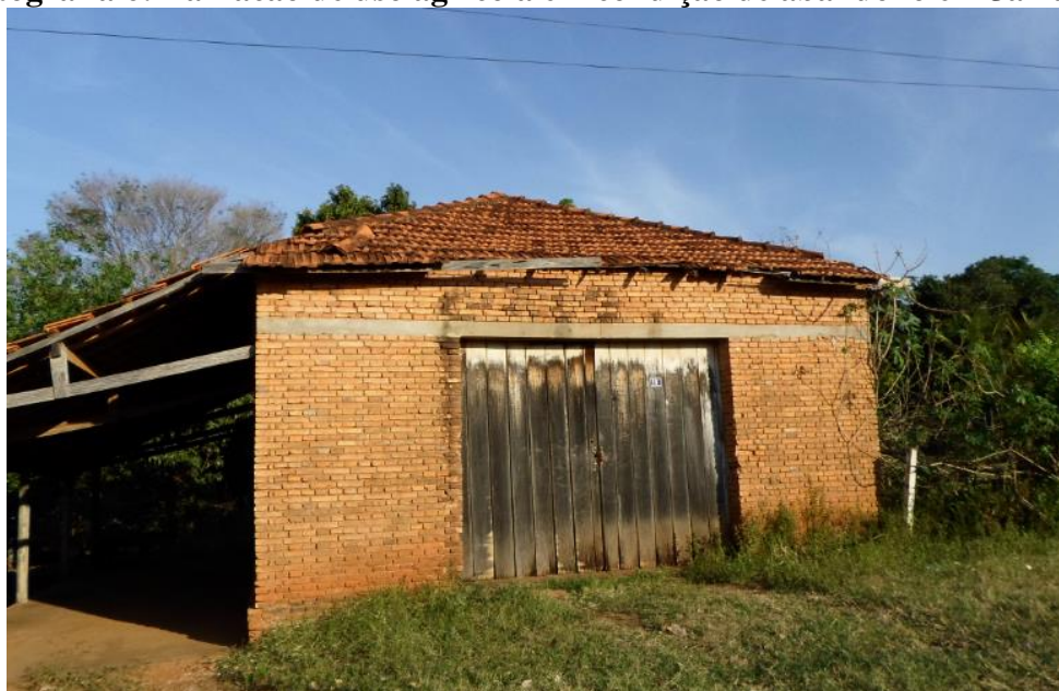
Fotografia 6: Barracão de uso agrícola em condição de abandono em Jamaica.
