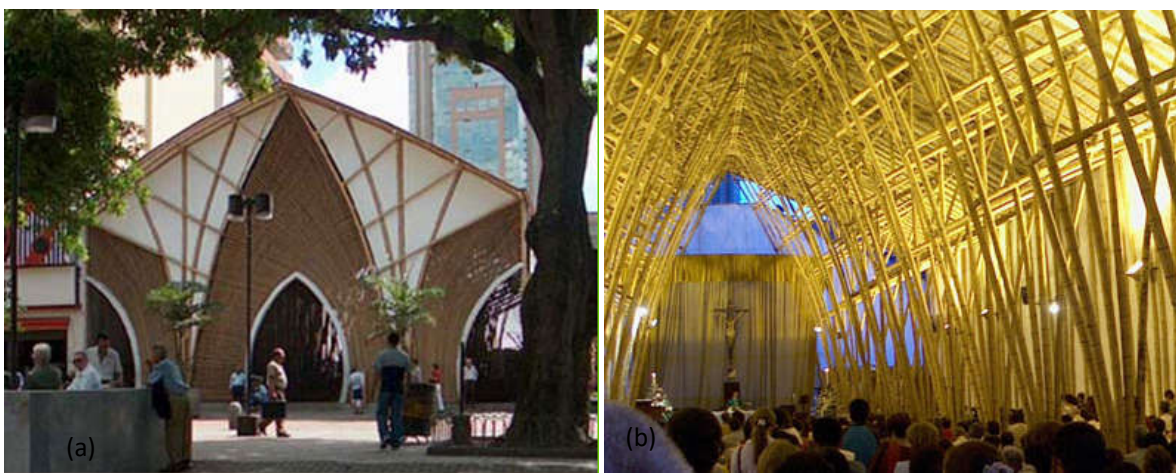
Figura 21 – Vista externa (a) e interna (b) da Catedral de Pereira, Colômbia
