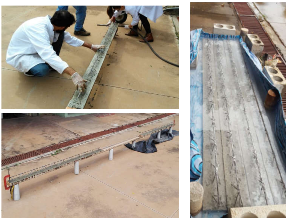
Figura 44 – Concretagem e cura das vigotas
