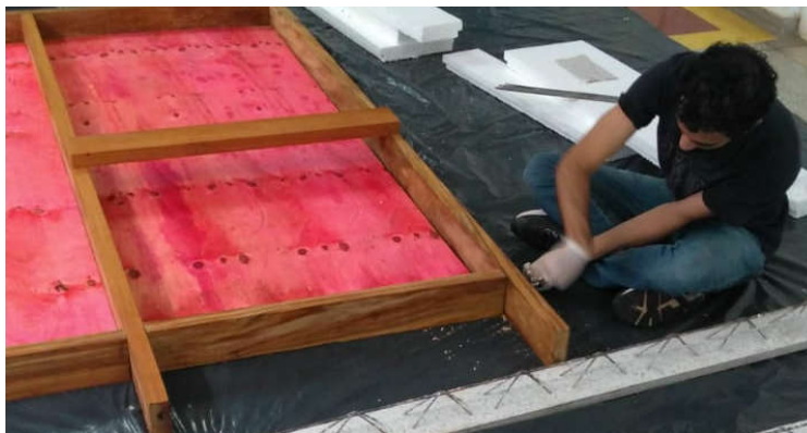
Figura 47 – Fôrmas das lajes
