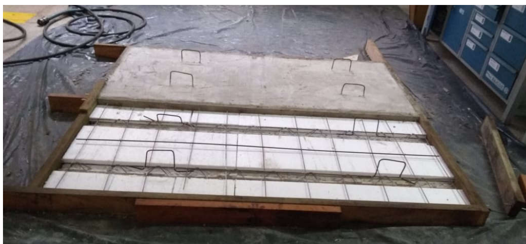
Figura 49 – Posicionamento final das armaduras e ganchos
