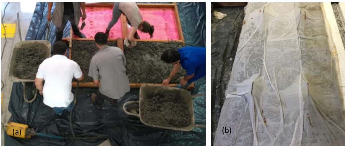
Figura 50 – Concretagem, adensamento (a) e cura da laje (b)
