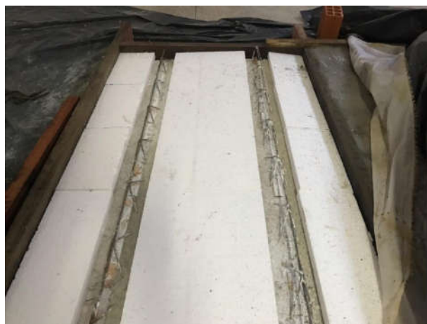
Figura 48 – Posicionamento das lajotas e vigotas
