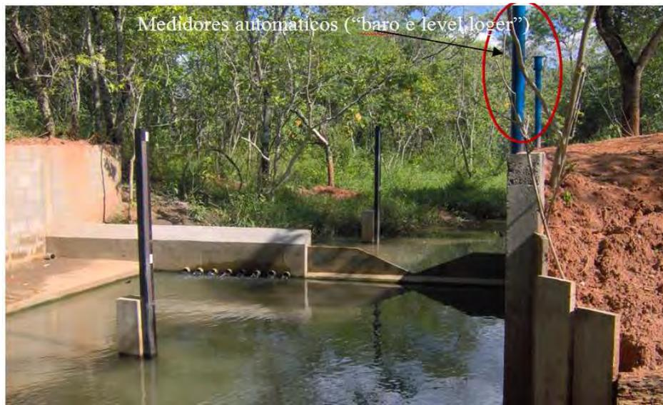
**Figura 8 – Vertedouro instalado no Ribeirão do Arrependido**
