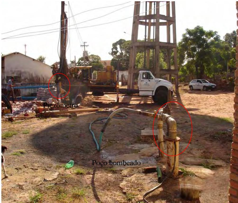
**Figura 6 – Instalação de piezômetro em Herculândia**
