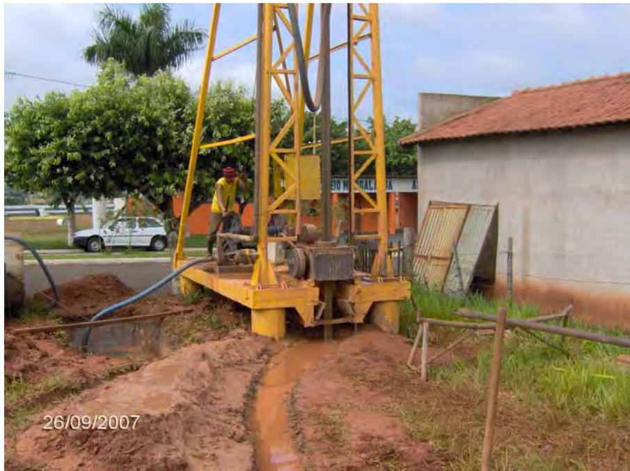
**Figura 3– Equipamento para perfuração de poços estratigráficos (Piacatu)**
