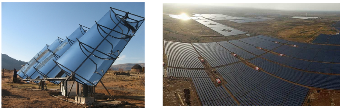
Figura 2.2. (a) Coletor Solar do tipo Calha Parabólica, (b) Painéis Solares Fotovoltaicos (QUOILIN, 2011), (GOMES, 2017).
