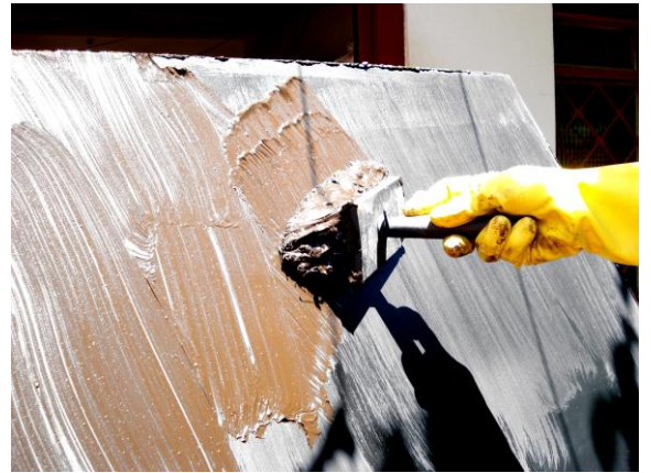
Fig. 111 detalhe da aplicação da massa asfáltica Casa-Trabalho , 2008 ateliê da cidade de Esteio, RS
