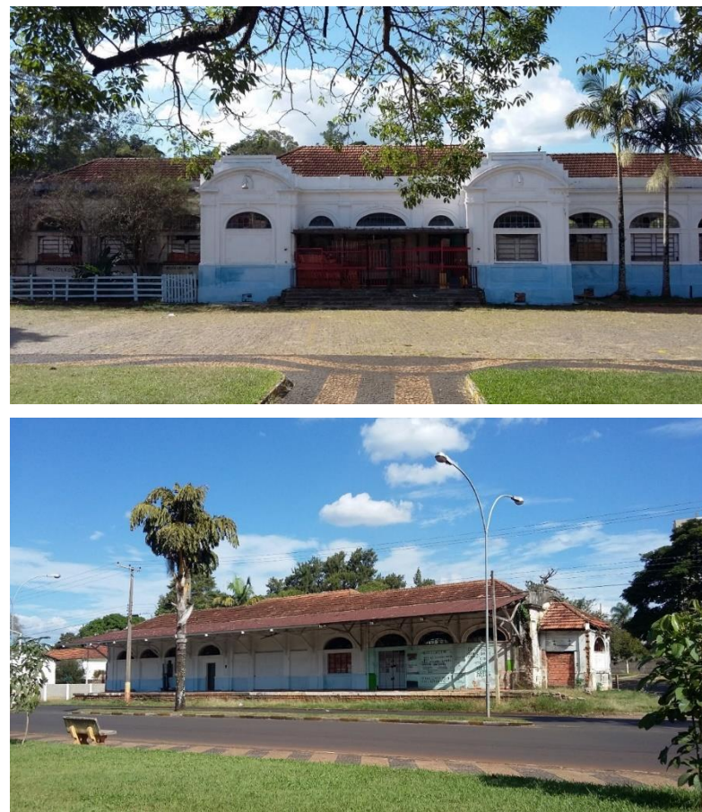
FIG. 21 — ANTIGA ESTAÇÃO FERROVIÁRIA AVAREENSE — SITUAÇÃO EXTERNA.
