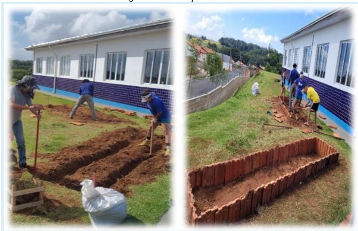
Figura 6 – Construção dos canteiros
