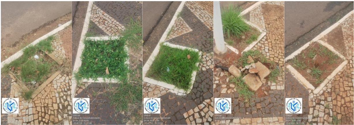
Figura 31 - Ausência de arborização demarcada nos segmentos AVBN_D_5 e AVBN_E_6.
