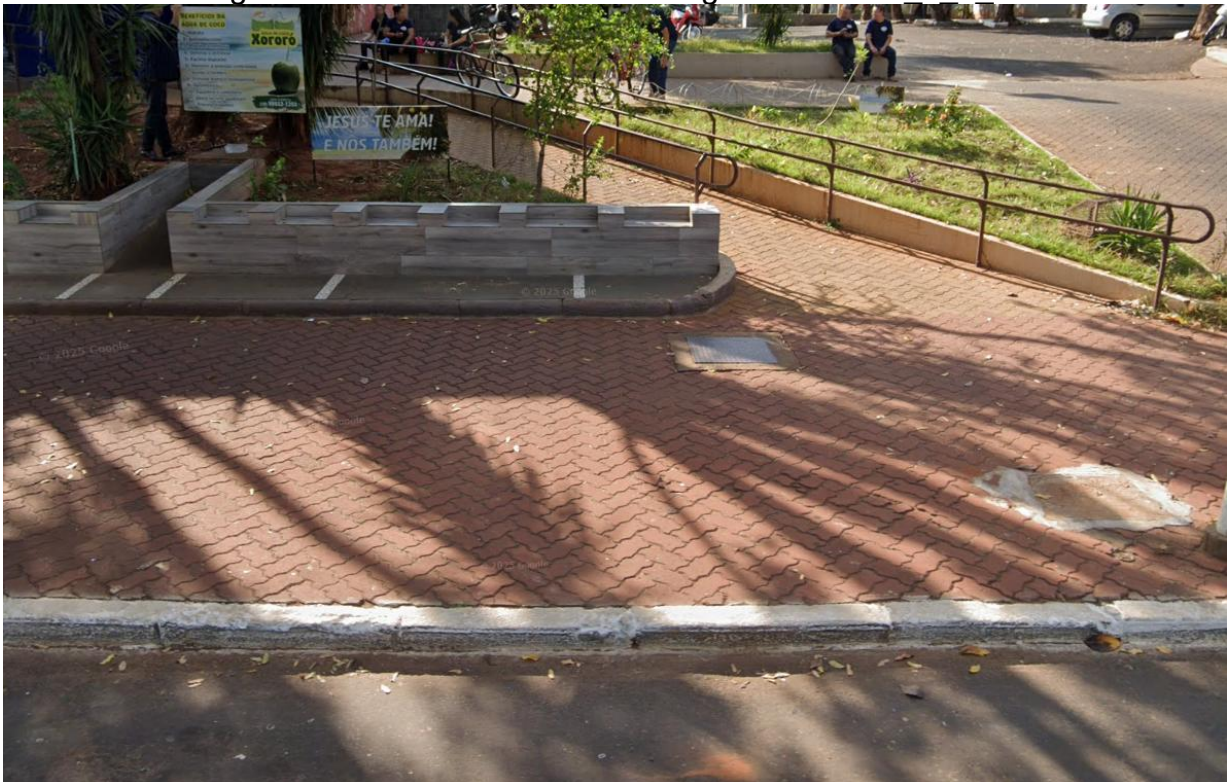
Figura 16 - Piso Intertravado no Segmento AVBN 1 1 B
