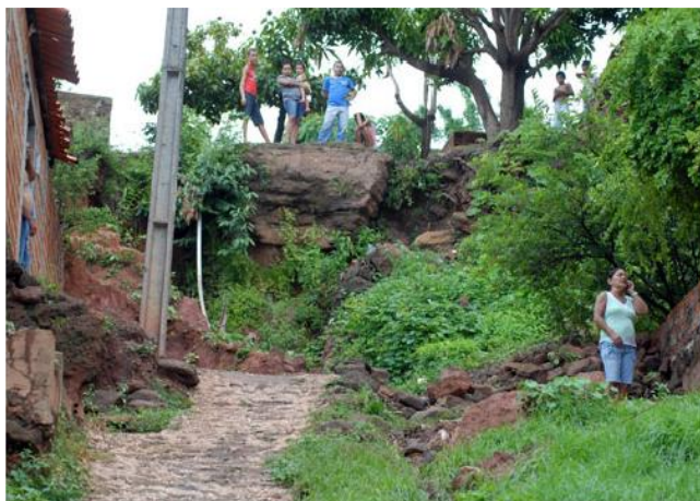
Figura 72: Rua Lions, localizada no bairro Satélite e construída em terreno íngreme que apresenta risco de deslizamento durante precipitação intensa.
