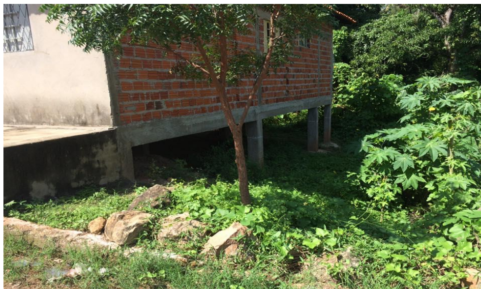
Figura 112: Casa construída suspensa na rua Equador, bairro Três Andares, zona sul de Teresina.
