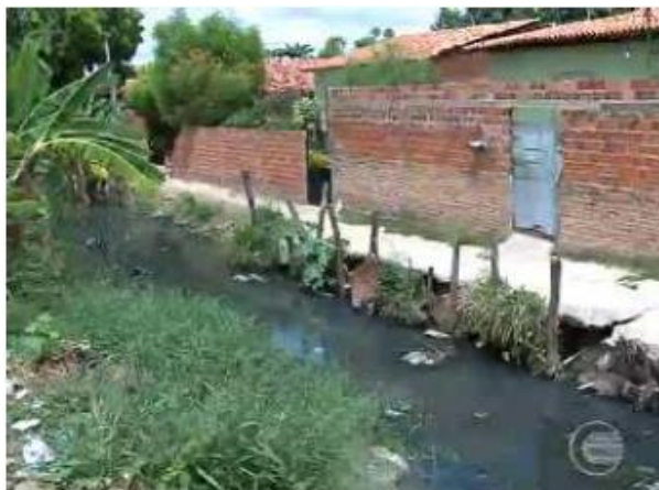
Figura 64: Esgoto a céu aberto localizado no bairro Nova Brasília, zona norte de Teresina, resultante de uma galeria inacabada presente no local.
