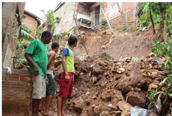
Figura 74: Casa atingida pelo deslizamento de terra, no bairro Parque Rodoviário, zona sul de Teresina.
