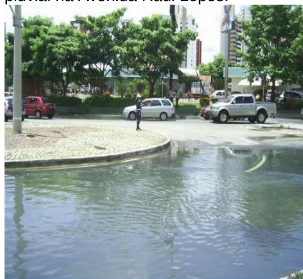
Figura 80: Refluxo de água da drenagem pluvial na Avenida Raul Lopes.
