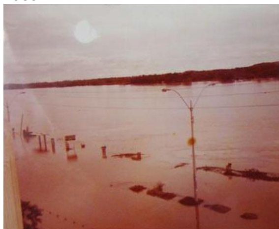
Figura 84: Avenida Maranhão, zona central da cidade, inundada com o transbordamento do rio Parnaíba em 1985.
