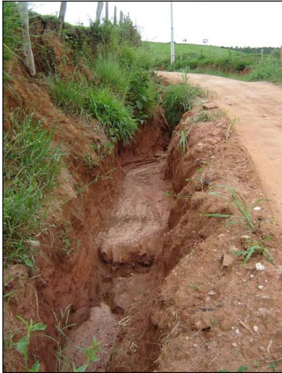
**Figura 35: Trecho de estrada de terra com erosão. Fonte: Lima (2007).**
