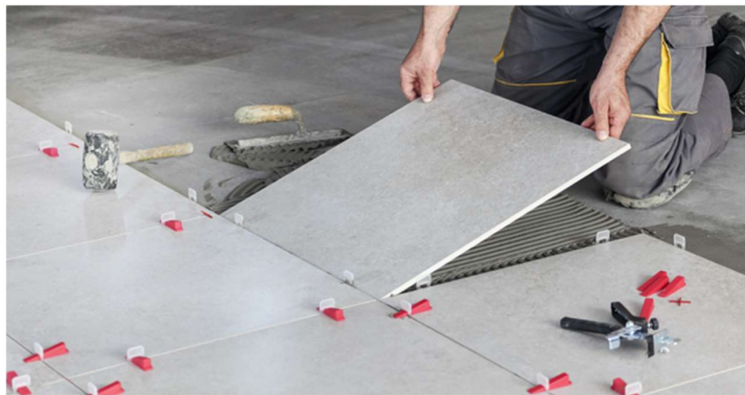
Figura 2 - Assentamento de revestimento cerâmico
