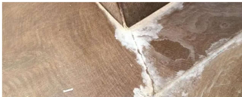
Figura 10 - Eflorescência em revestimento cerâmico
