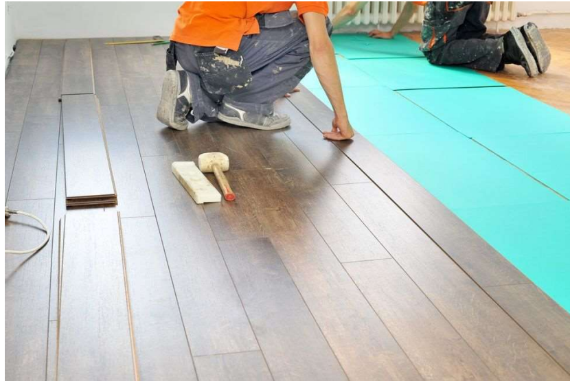
Figura 7 - Instalação de revestimento laminado
