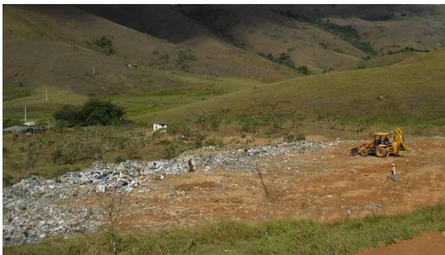
Figura 28. Vista Geral do Aterro Controlado do Município de Bananal. Fonte: Prefeitura Municipal de Bananal (2010)
