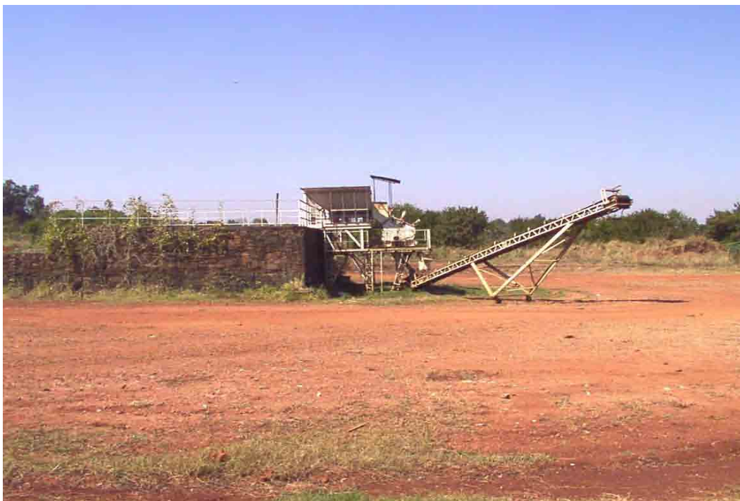
Foto 2.12(ago2003) - Usina de moagem de Ribeirão Preto-SP. Modelo chamado de piloto, da esquerda para a direita, plataforma de abastecimento, alimentador vibratório, moinho de martelos e esteira móvel.
