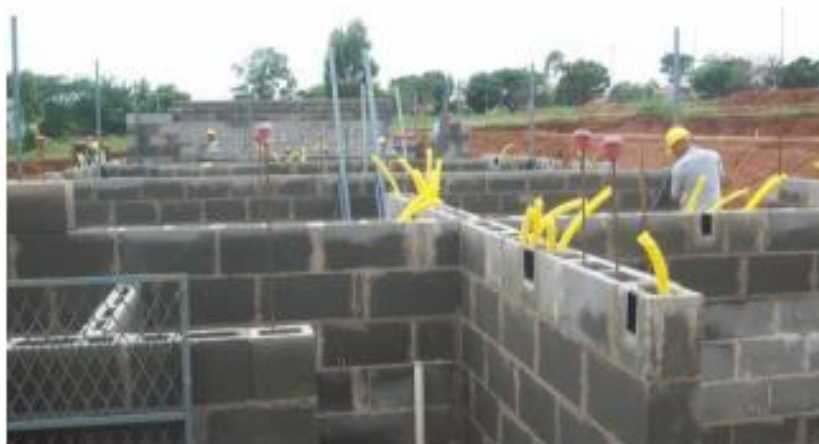
Figura 23 – Elevação da alvenaria até a 5ª ou 6ª fiada
