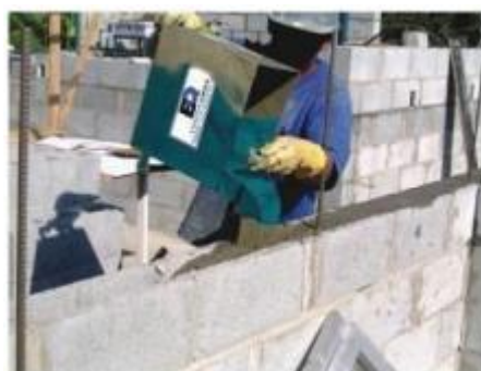
Figura 24 – Lançamento de graute
