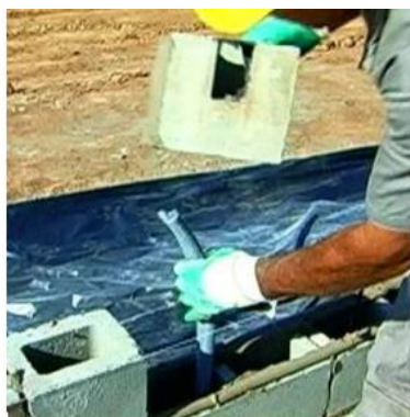
Figura 21 – Execução de primeira fiada
