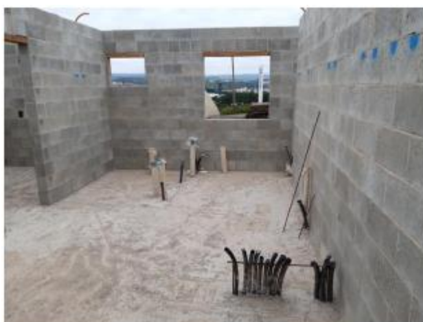
Figura 25 – Elevação da alvenaria até a última fiada
