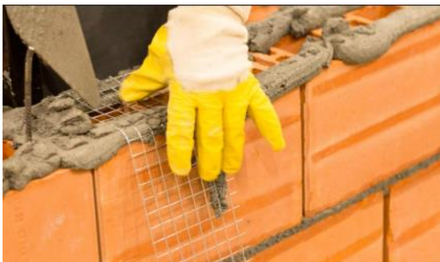
Figura 9 – Argamassa de assentamento
