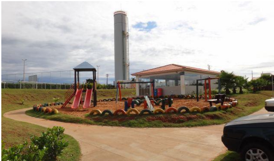
Figura 3 - Interior do condomínio Moradas Marília
